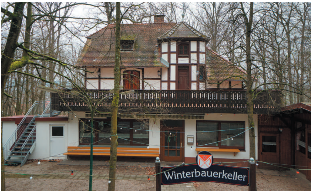
Wirtschaftsgebäude, Ansicht von Süden, © memvier 2023
