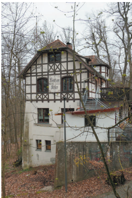
Wirtschaftsgebäude, Ansicht von Süden © memvier 2023
