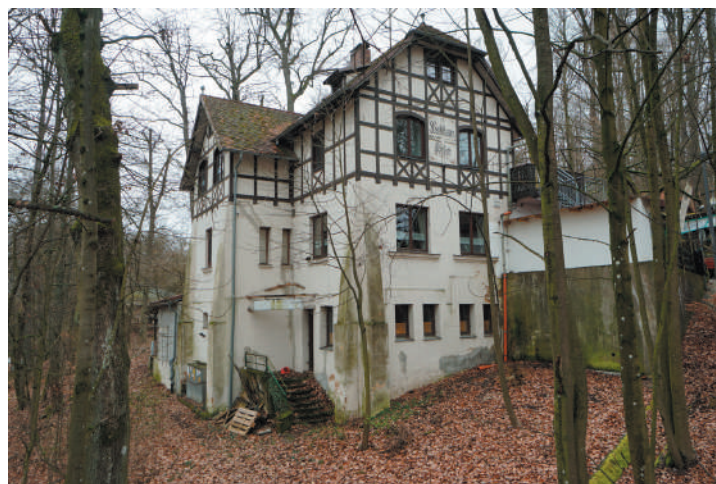
Wirtschaftsgebäude, Ansicht von Südwesten, © memvier 2023
