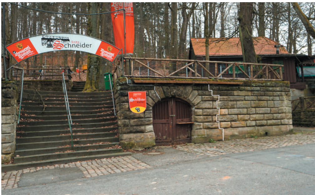
Eingang zum Kellerstollen, Ansicht von Norden; weiß ist die vertikale Baufuge der Terrassenerweiterung eingezeichnet. © memvier 2023
