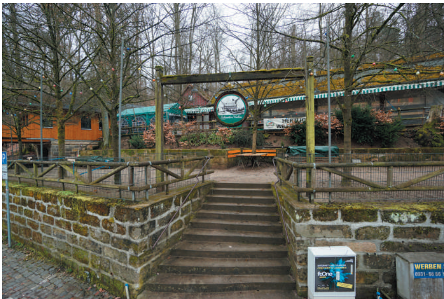
Schindler-Keller 1993, Ansicht von Westen, © memvier 2023
