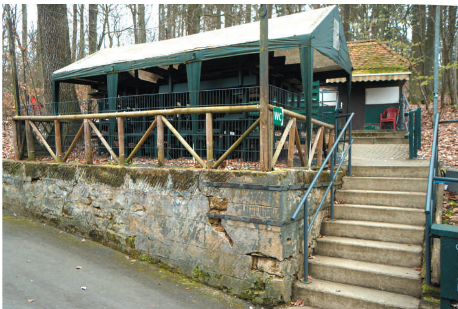
Gesicherte Stützmauer an den oberen Terrassen des Rappen-Kellers, © memvier 2023
