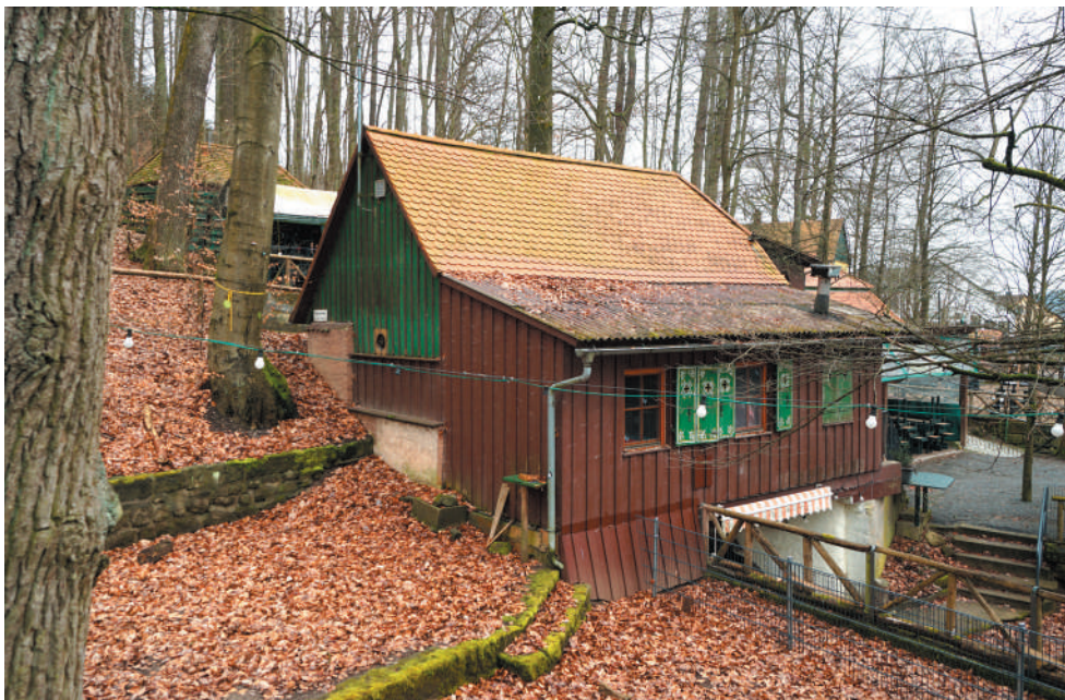
Kellerhaus mit Anbau, Ansicht von Norden, © memvier 2023
