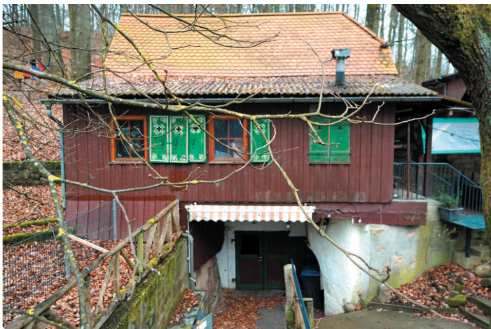
Kellerhaus mit Anbau, Ansicht von Nordwesten, © memvier 2023
