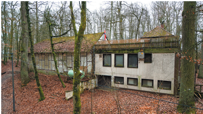
Bierhalle und Erweiterungsbau, Ansicht von Nordost © memvier 2023
