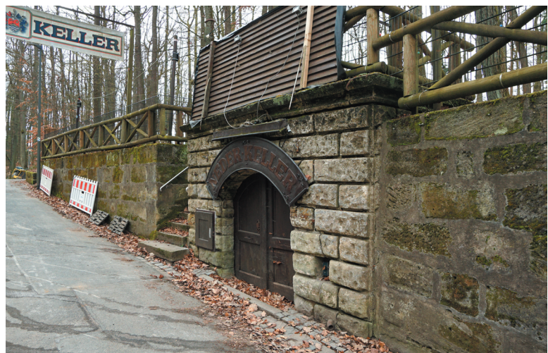
Eingang zum Felsenkeller, Ansicht von Nordost © memvier 2023
