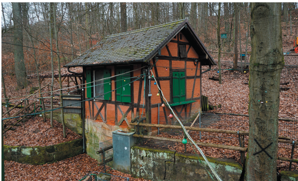
Kellerhäuschen in achwerkbauweise, Ansicht von Nordwesten, © memvier 2023
