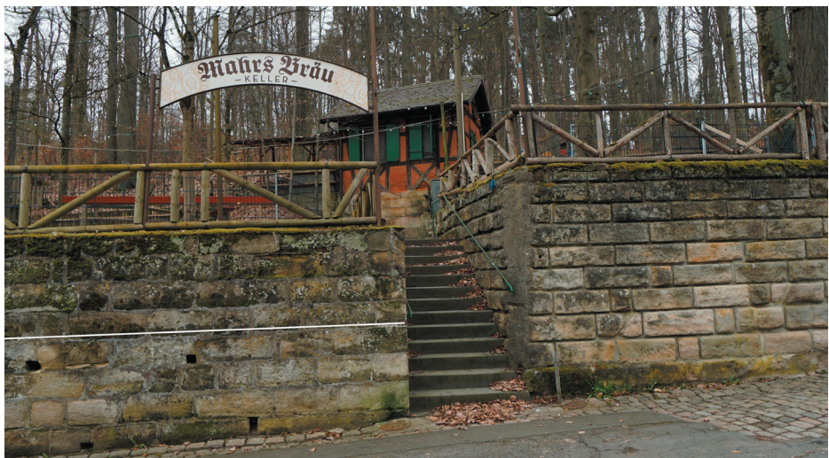
Mahrs-Keller mit Kennzeichnung der horizontalen Baufuge auf der Terrassenmauer (Mauererhöhung 1927). © memvier 2023
