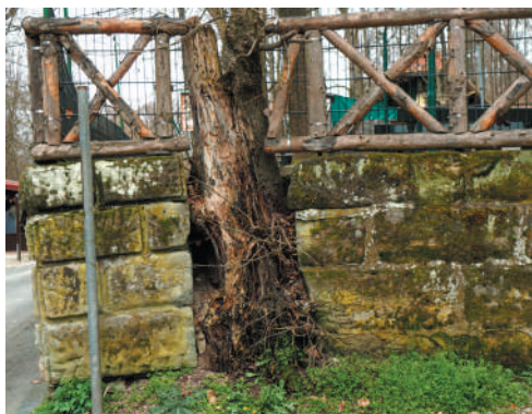
Ansicht Terrassenmauer Südwest, Ecke © memvier 2023
