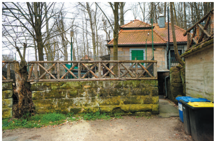
Ansicht Terrassenmauer Südwest, rechter Teilbereich, © memvier 2023
