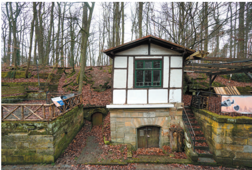
Kellereingang mit Kellerhaus, Ansicht von Osten, © memvier 2023
