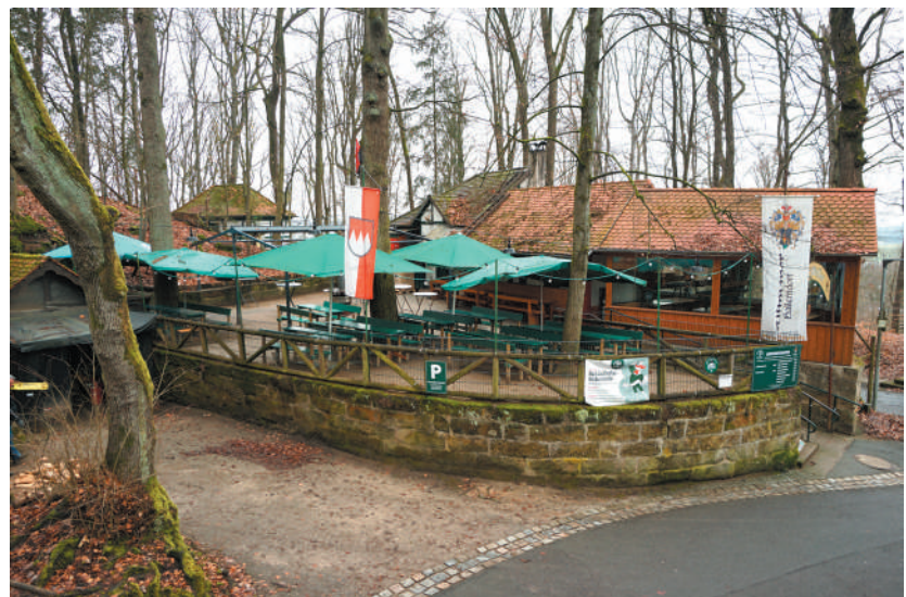
Glockenkeller, Ansicht von Süden © memvier 2023
