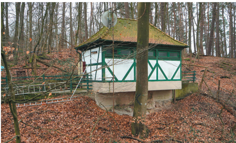
Toilettenhaus, Ansicht von Nordwesten, © memvier 2023
