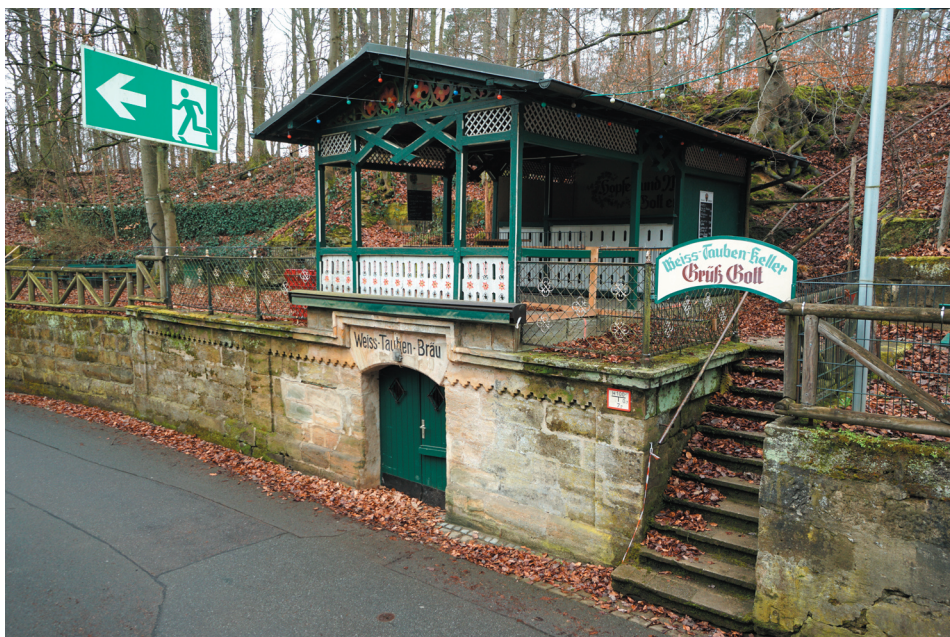
Ansicht des Kellereingangs von Nordosten, © memvier 2023
