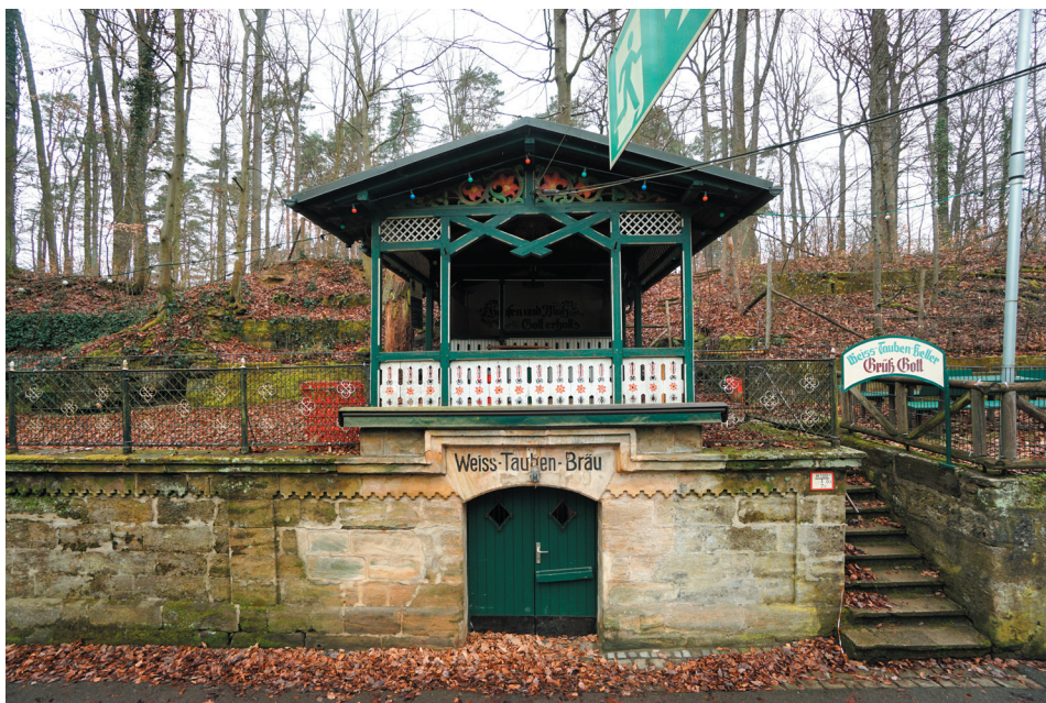
Zugang zum Felsenkeller mit darüberliegendem Salett, © memvier 2023
