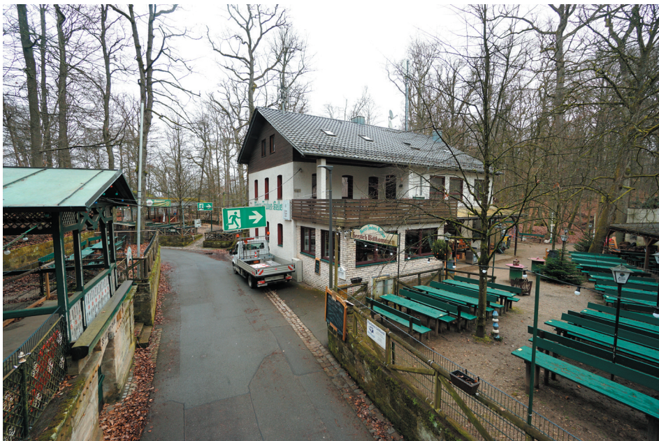
Wirtschaftsgebäude, Ansicht von Südwesten, © memvier 2023
