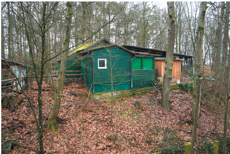
Rückwärtige Ansicht der Kellerbebauung, © memvier 2023
