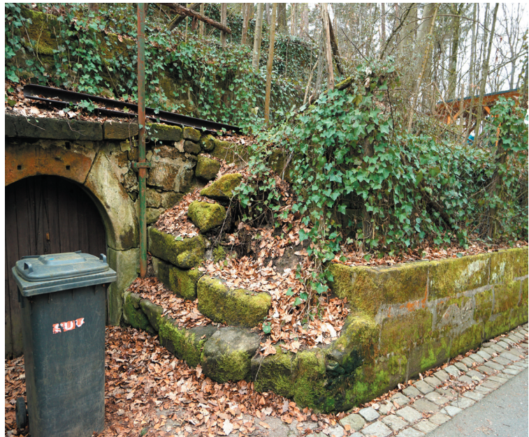
Vorgesetzte Terrassenmauer vor dem Kellereingang, © memvier 2023
