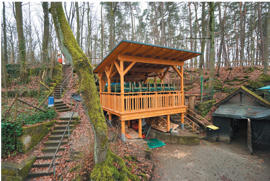
Bühne über dem Zugang zum Schorr-Kellerstollen, Ansicht von Norden, © memvier 2023
