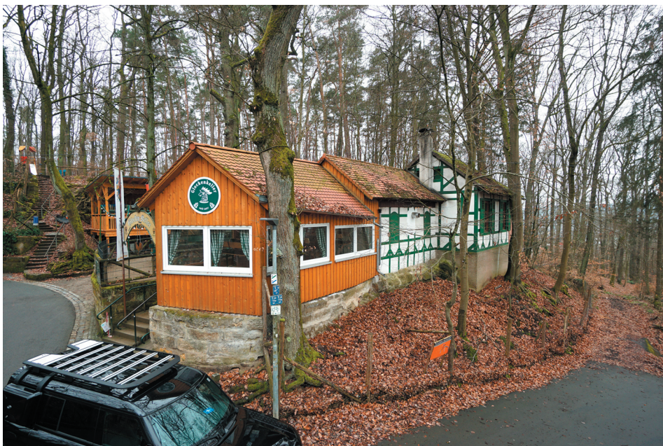
Schankhaus (mittiges Gebäude) mit Erweiterungsbauten, Ansicht von Nordosten, © memvier 2023
