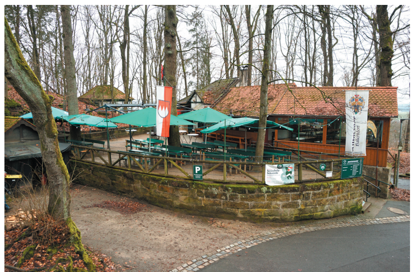
Glockenkeller, Ansicht von Süden © memvier 2023
