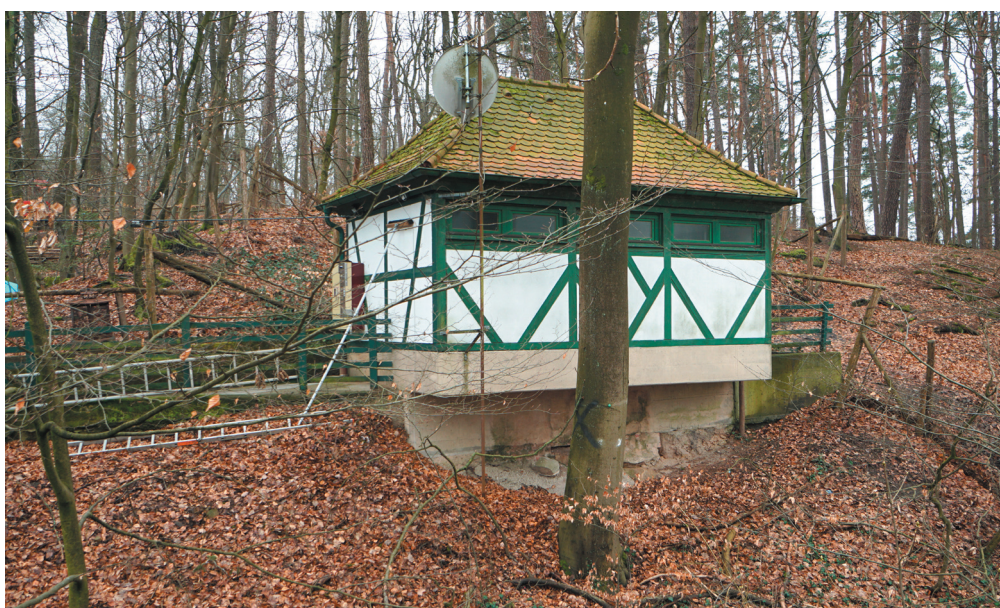
Toilettenhaus, Ansicht von Nordwesten, © memvier 2023
