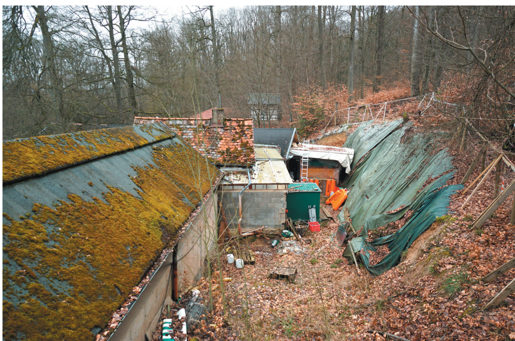
Überblicksfoto des Bereichs inter em Schindler-Keller mit Hang- und Absturzsicherungen, © memvier 2023
