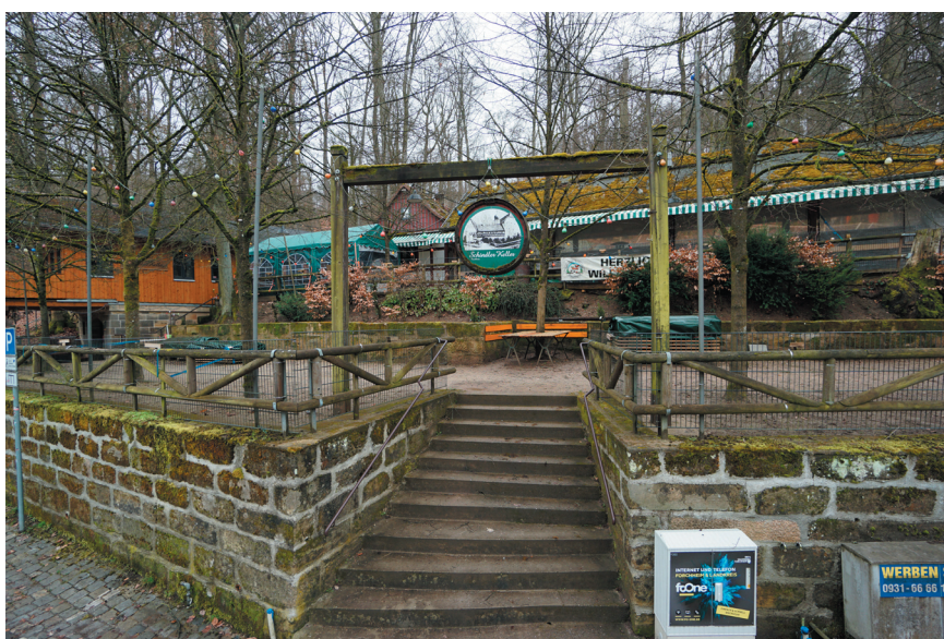
Schindler-Keller 1993, Ansicht von Westen, © memvier 2023
