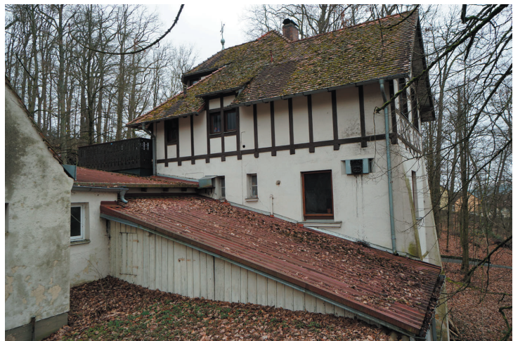
Wirtschaftsgebäude, Ansicht von Norden, © memvier 2023
