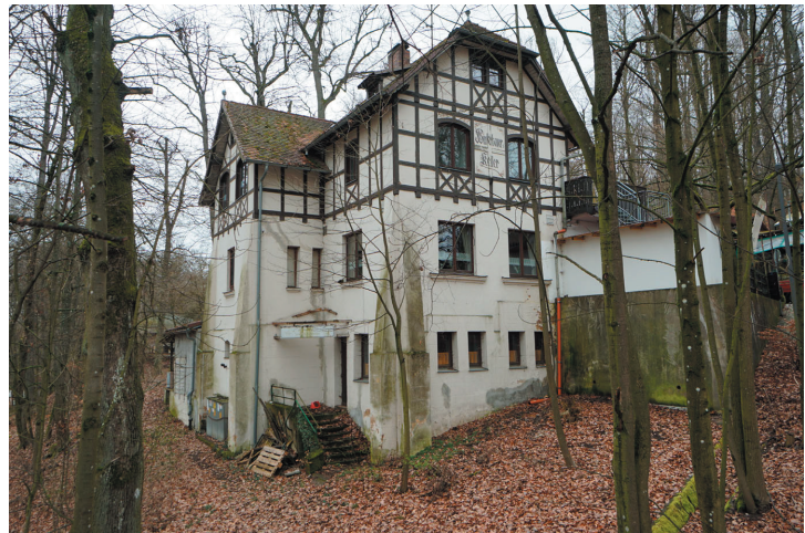
Wirtschaftsgebäude, Ansicht von Südwesten, © memvier 2023
