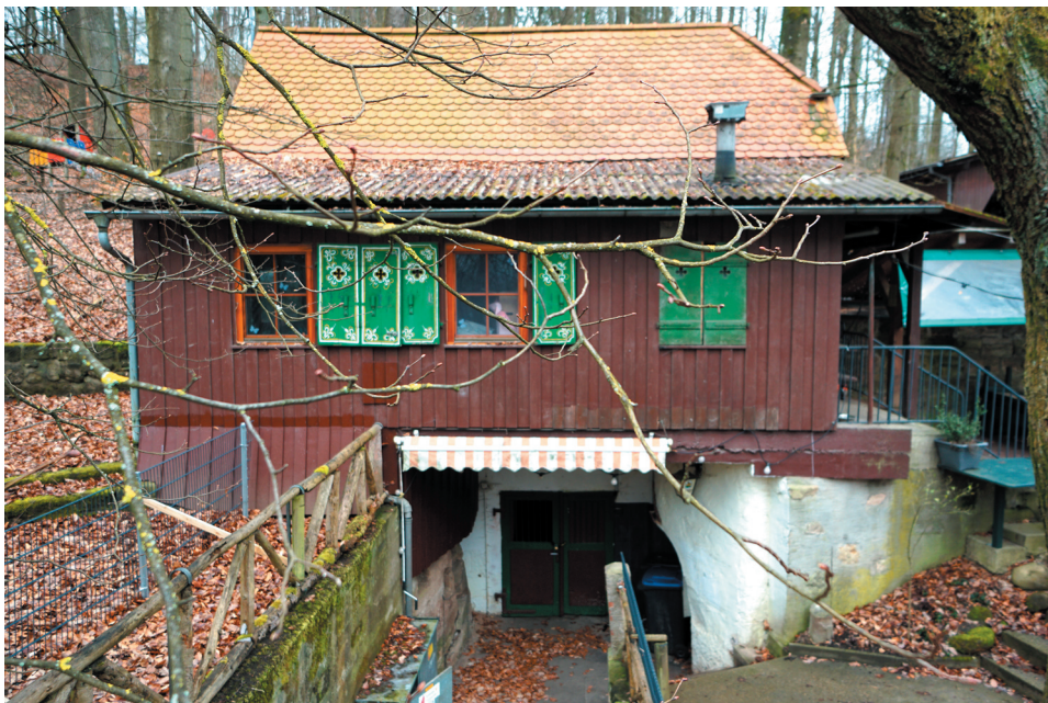
Kellerhaus mit Anbau, Ansicht von Nordwesten, © memvier 2023
