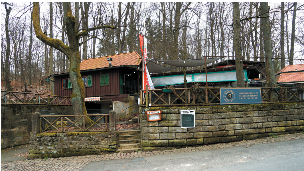
Rappen-Keller von der unteren Kellerstraße, © memvier 2023
