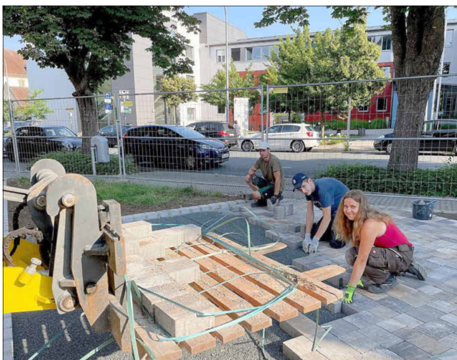
Noch viel zu tun: Die Auszubildenden der Stadt helfen fleißig beim Pflastern.
