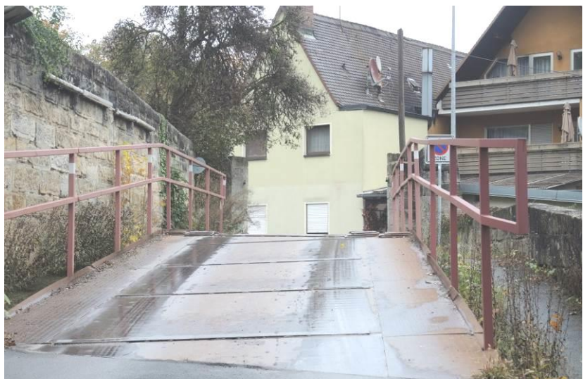
Abbildung 86: Zufahrtsbereich Altes Krankenhaus
