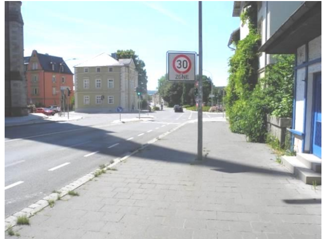
Abbildung 24: saniert: Innstadteinfahrt vom Bahnhof, Eisenbahnstraße
