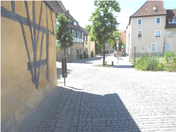
Abbildung 23: saniert: Wiesentstraße Höhe Kasernstraße
