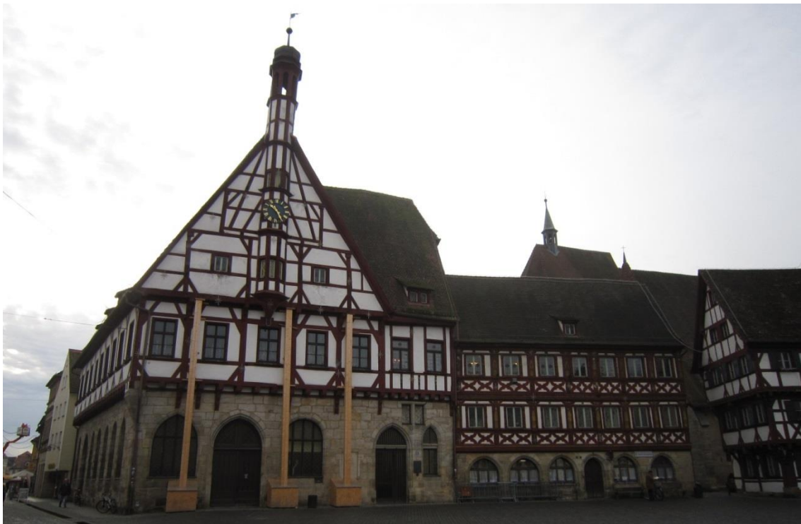
Abbildung 3: Die Nordseite des Rathauses Forchheim
