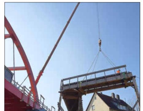
Der Gehweg führt derzeit bereits provisorisch über die neue Stahlbogenbrücke und der Rückbau der Behelfsbrücke hat begonnen. Foto: DB Netz AG
