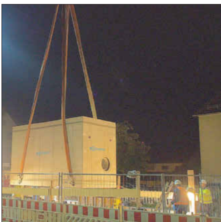
Einhebung eines Drosselbauwerks Foto: Stadtwerke Forchheim GmbH
