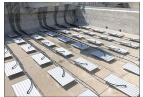
Der erste neue Teil der energieeffizienten Belüftungsanlage für das Belebungsbecken.
