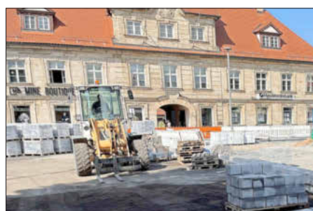
Paradeplatz im Umbau. Foto: S. Böhm
