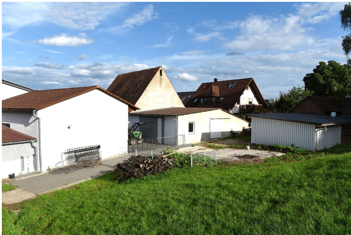
Abb. 5: Nebengebäude und Scheune von Nordwesten
