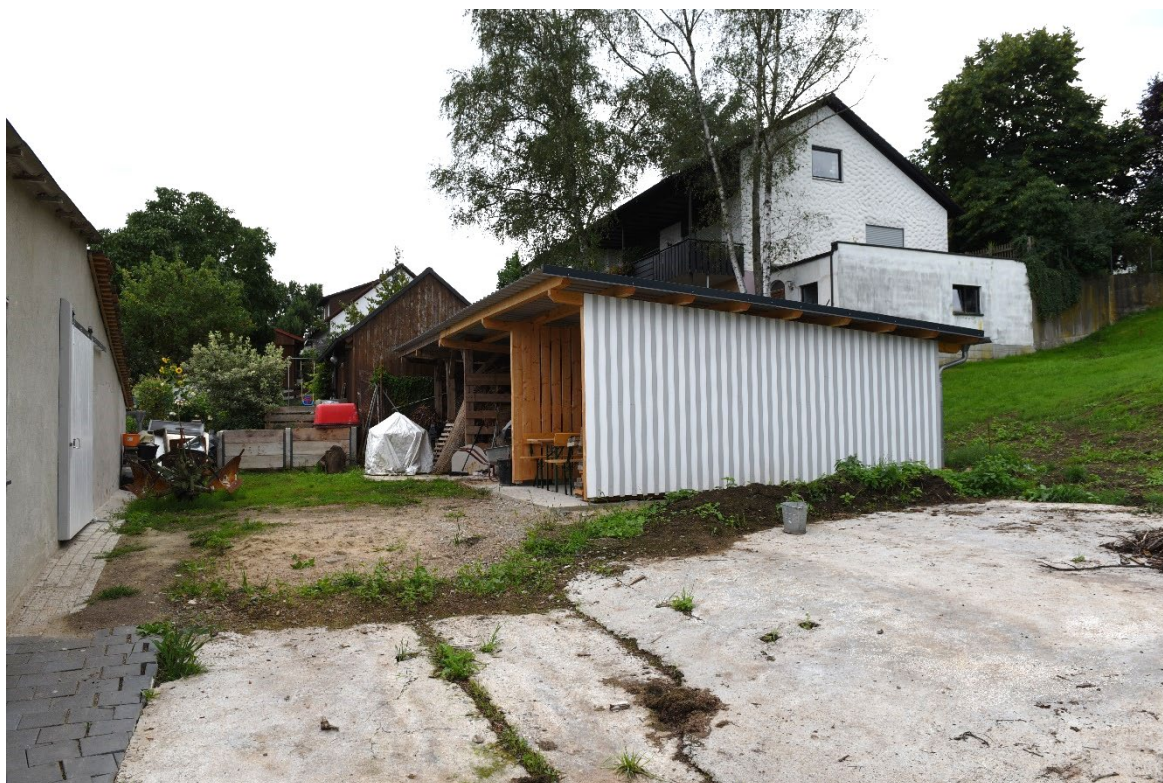
Abb. 6: Pultdachgebäude (Ersatzbau hinter bestehender Scheune) von Norden
